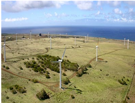
Haw'i Wind Farm
