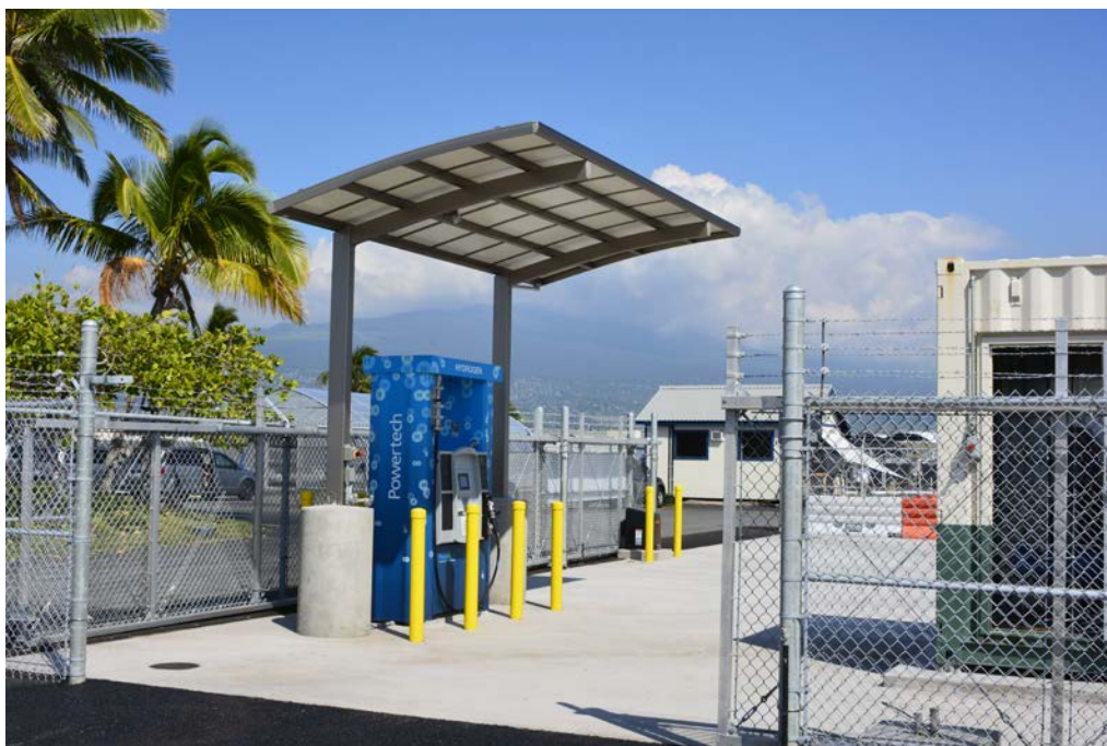
Figure 4. NELHA 350-bar dispenser
